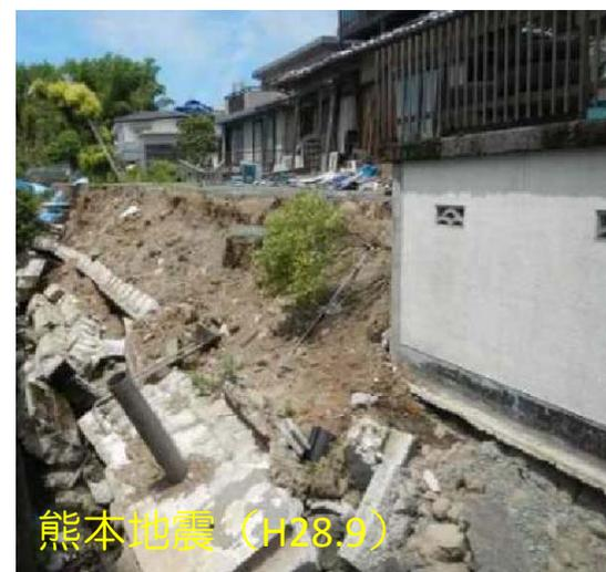
●2016年熊本地震の際、南阿蘇村高野台地区の緩傾斜地の崩壊（上図）と益城町の人口斜面崩壊状況（下図）
